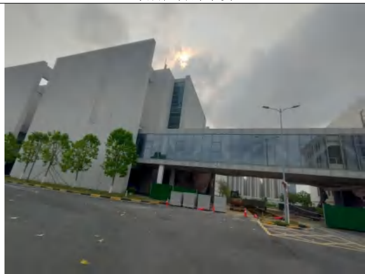
项目厂界外西侧
