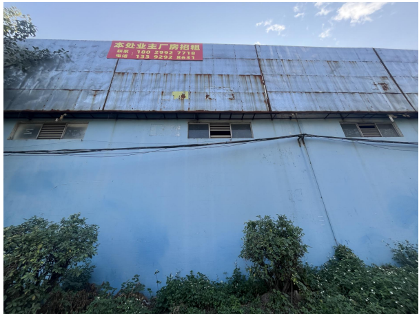
项目厂界外东北面(同栋)工业厂房
